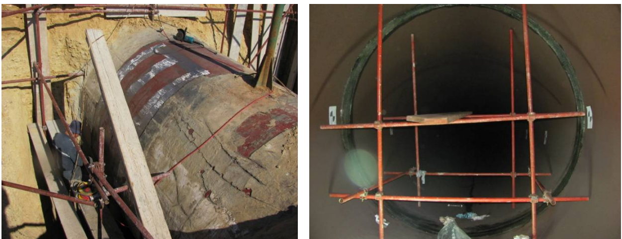
a) Priprema brušenjem spoljašnjeg dela
