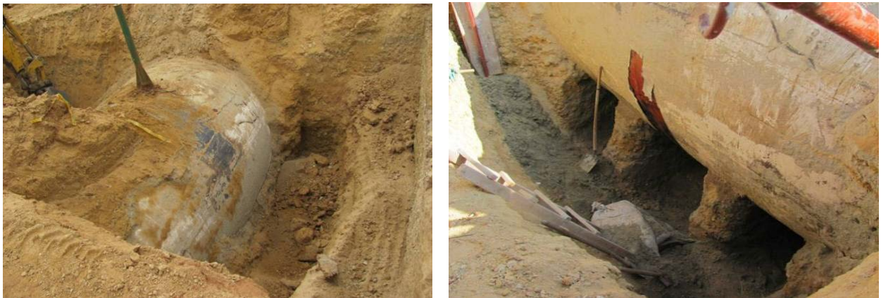
Sl.2. Prikaz otkopavanja cevovoda
