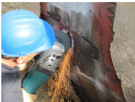
a) Prikaz pripreme prsline za sanaciju
