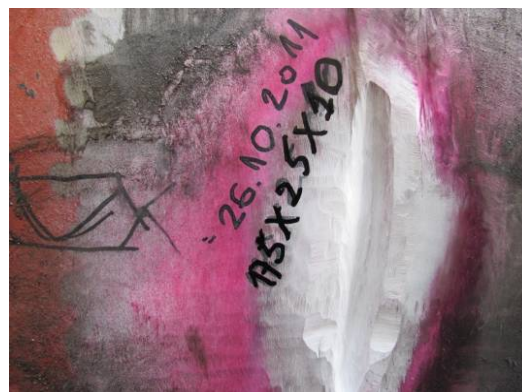
b) Jedna od prsline u ZS priprmljena za sanaciju
