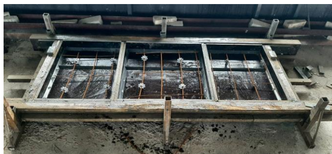
Slika 19. Priprema oplate za ivične vence.
