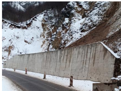
Slika 1b. Potporni zid izveden nakon odrona 2017g.
