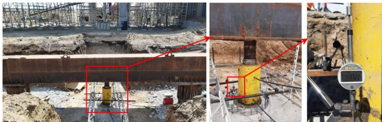
Slika 7. Konstrukcija sistema za opit probnog opterećenja šipa
