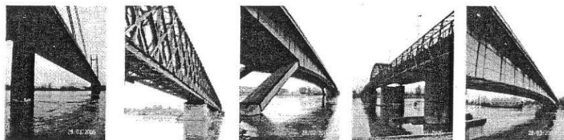
a) višeci b) rešetkasti c) gredni sa podupiračima d) sa konzolnim nosačima e) kontinualno gredni
