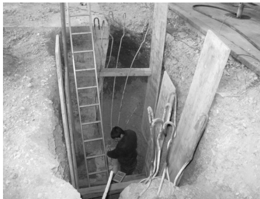
Slika 11. Ispitivanje šipa bez AB nastavka
