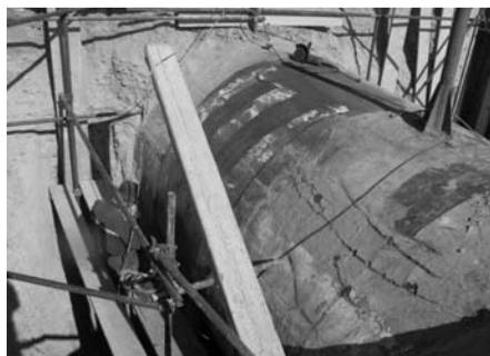
a) Brušenje spoljašnjeg dela cevovoda
