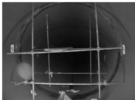
b) Brušenje unutrašnjeg dela cevovoda
