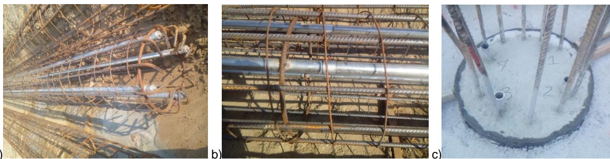
Slika 12. a) i b) čelične cevi spojene i zavarene za unutrašnju stranu armaturnog koša šipa; c) krajevi cevi koji vire nakon betoniranja
