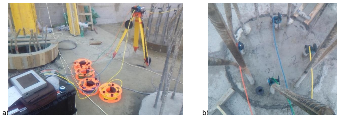
Slika 13. a) tripod za kablove sa sensorima, uređaj za akviziciju, memorisanje, procesiranje i vizuelizaciju podataka povezan sa sondama; b) povezane i postavljene sonde u cevima
