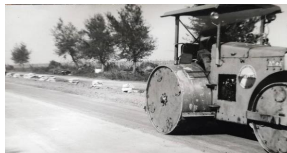
Slika 4. Izrada cementne stabilizacije (period 1955. - 1960. godina)
