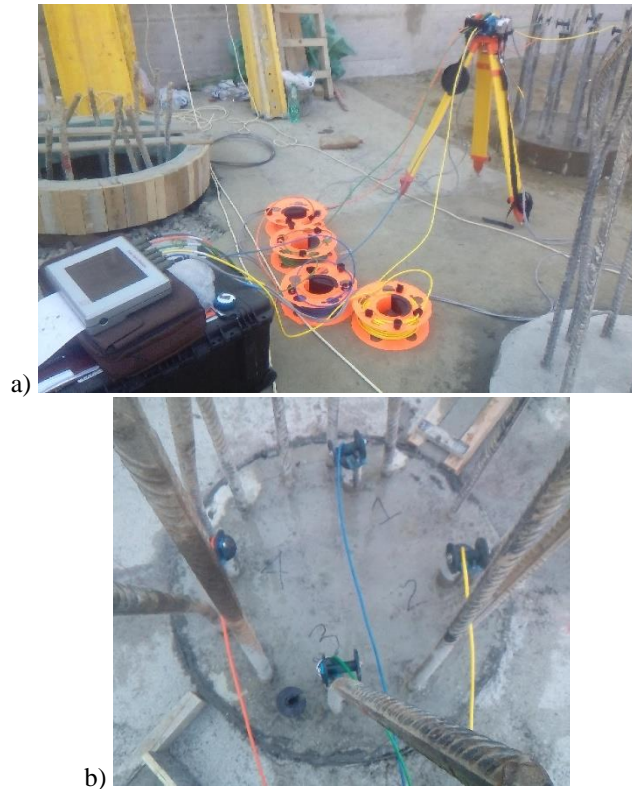
Slika 11. a) tripod za kablove sa sensorima, uređaj za akviziciju, memorisanje, procesiranje i vizuelizaciju podataka povezan sa sondama, b) povezane i postavljene sonde u cevima [7]
