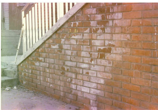
Sl. 10: Prikaz brašnjavog raspadanja opeka kao posledica iscvetavanja rastvornih soli iz opeka
