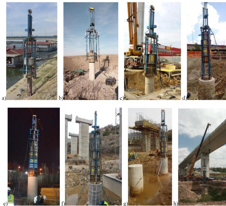
Slika 12. Test dinamičkog opterećenja šipa (DLT) - setovana oprema za ispitivanja: a) Savska promenada, b) vetropark Malibunar, c) Aviv Park u Beogradu, d) pristupna saobraćajnica za most na Adi, e) poslovno-komercijalna zgrada-kula Ušće 2, f) mostovi na trasi ekspresnog puta Gradsko-Prilep u Makedoniji, g) mostovi na koridoru X i XI, h) vijadukti na trasi autoputa E 70/E 75 [7]
