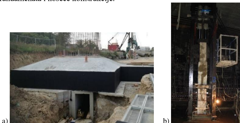
Slika 7. Test statičkog opterećenja šipa (SLT) - reaktivni sistem: a) vijadukti za brze pruge u Čortanovcima u Srbiji (reaktivni sistem formiran od armirano-betonske stope - naglavne temeljne ploče za šipove), b) poslovni centar MFC Ušće u Srbiji (reaktivni sistem formiran odupiranjem presa o noseću konstrukciju) [7]
