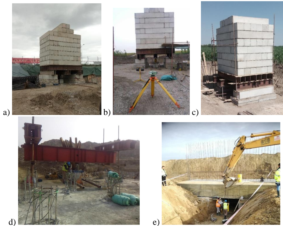
Slika 9. Test statičkog opterećenja šipa (SLT): a) termoelektrana i toplana TE-TO Pančevo, b) vetropark Alibunar , c) vetropark Izbište , d) vetropark Kovačica , e) most na autoputu E-763
