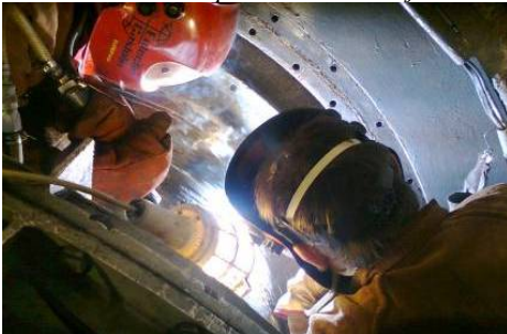
7c. izvođenje zavarivanja u ograničenom prostoru kapsule
