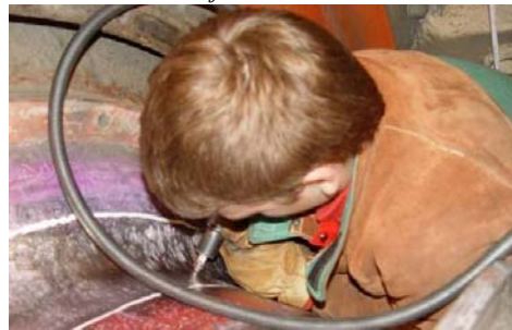
7d. iskivanje zavora pneumatskim čekićem sa ciljem relaksacije zaostalih napona od zavarivanja
